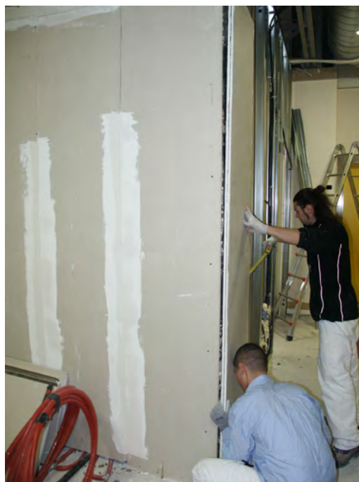
risolto piombo in angolo sale radiologiche - ospedale di Trecenta
