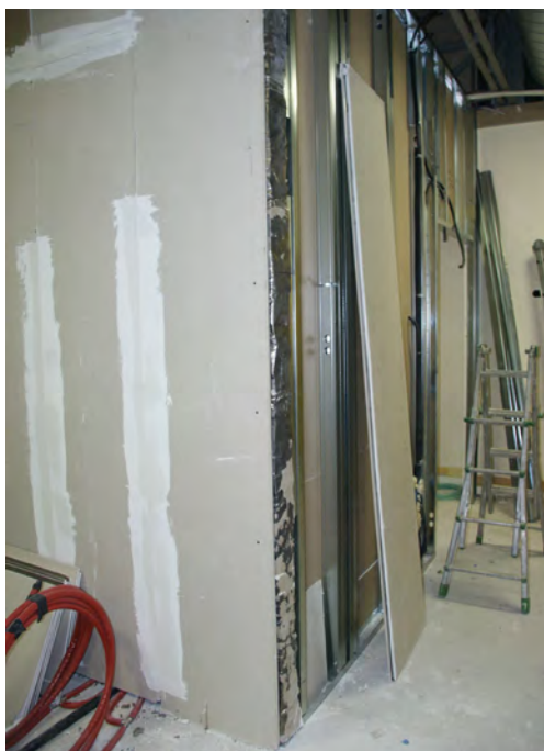
risolto piombo in angolo sale radiologiche - ospedale di Trecenta
